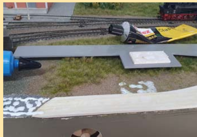
Auf dem vorhandenen Anschlussmodul waren dann auch Anpassungsarbeiten notwendig. Für die Unterfütterung des Straßenverlaufes benutzte ich passend starkes Balsaholz.
